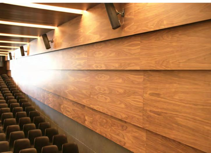
I **pannelli acustici in legno microforato MicroAcoustic** sono ideali per la realizzazione di **pareti acustiche** o rivestimenti murali installati con profili di montaggio Tecalum, e come **controsoffitti fonoassorbenti** con profili di montaggio modulare tipo T24.
