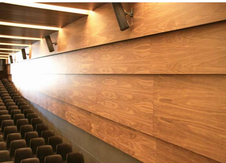
Les **panneaux acoustiques en bois micro-perforé MicroAcoustic** sont idéaux pour créer des parois acoustiques ou des revêtements muraux installés avec des profilés de montage Tecalum, et comme faux plafonds phonoabsorbants avec des profilés de montage modulaires de type T24. Selon le type de fixation choisie, les systèmes de montage peuvent être contrôlables ou non contrôlables.
